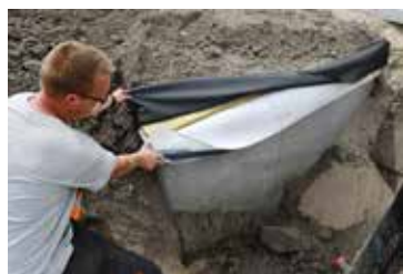
9) Voorzien van 5 lagen op de bovenplaten: folie, doek, isolatie, doek, folie
