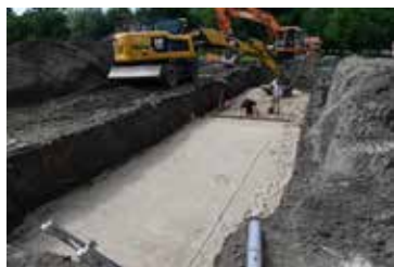
1) Uitgraven en egaliseren van de putten
